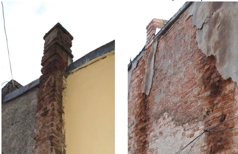
Coș de fum deteriorat și calcan, care se pot prăbuși în stradă la seism
