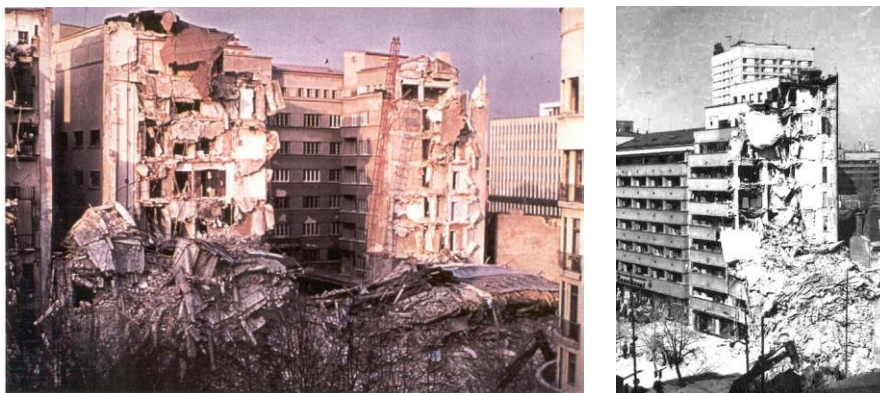
Fig. 4. Clădiri construite înainte de 1940, fără a fi proiectate să reziste la seisme, prăbușite la cutremurul din 4 martie 1977.
